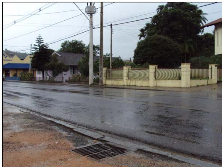
**Figura 37 – Caixa de drenagem com grelha, ao fundo residências em nível inferior ao da via**
