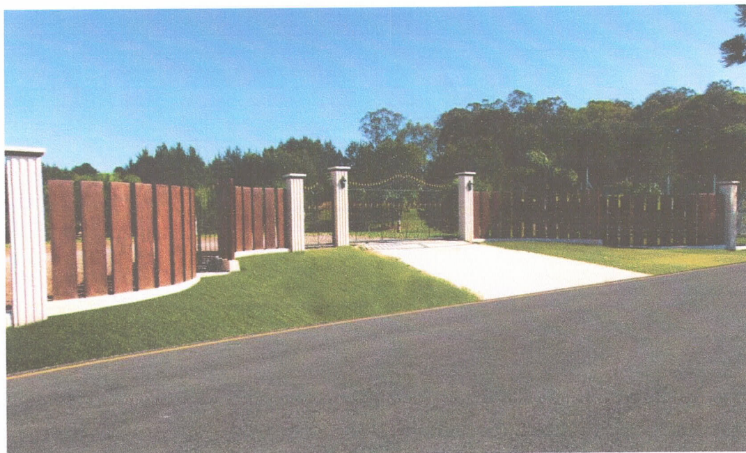
Exemplo de Cercamento com blocos e postes pintados.
