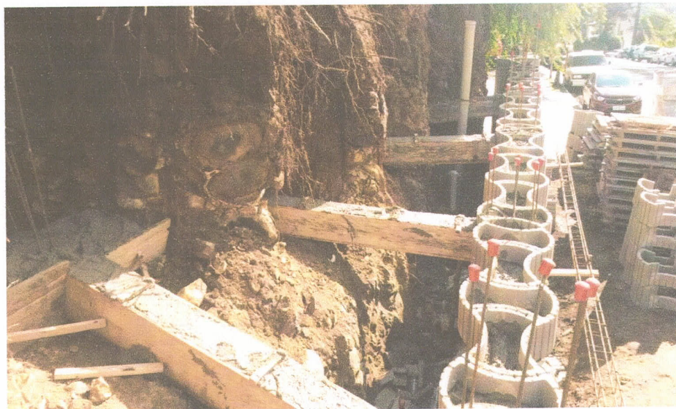
Modelo dos contrafortes de concreto engastados.
