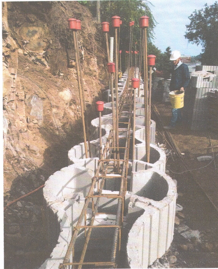
Exemplo de vigas e colunas internas ao muro.
