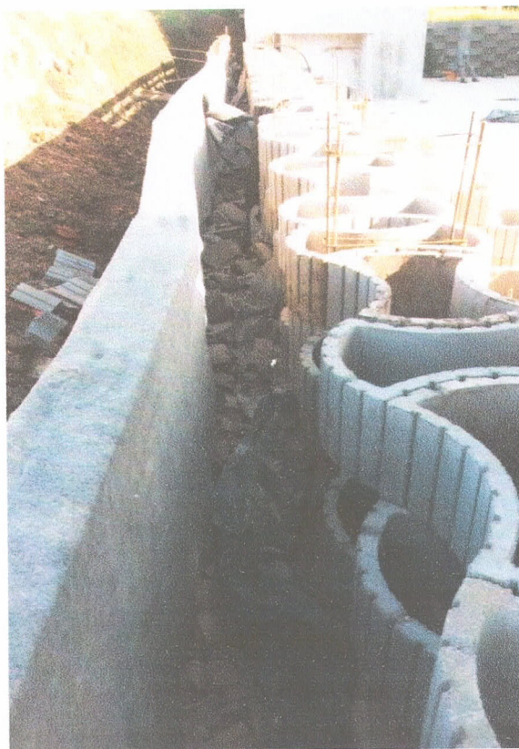
Exemplo de Drenagem do muro.
