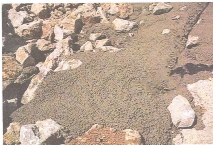
Exemplo de concreto ciclópico primeiras fiadas.
