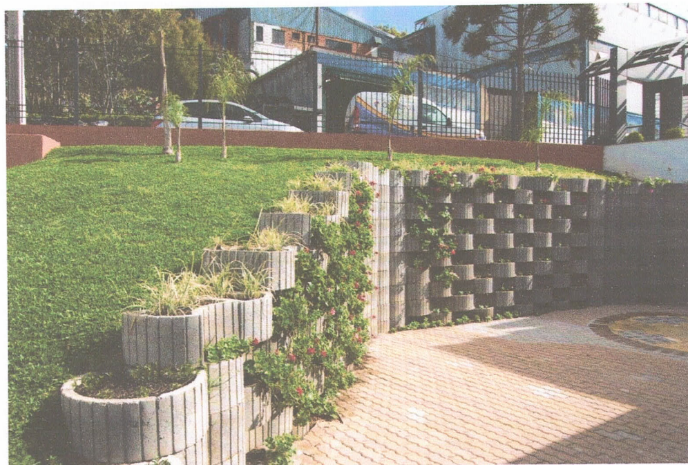
Exemplo de muro de blocos depois de finalizado com paisagismo.
